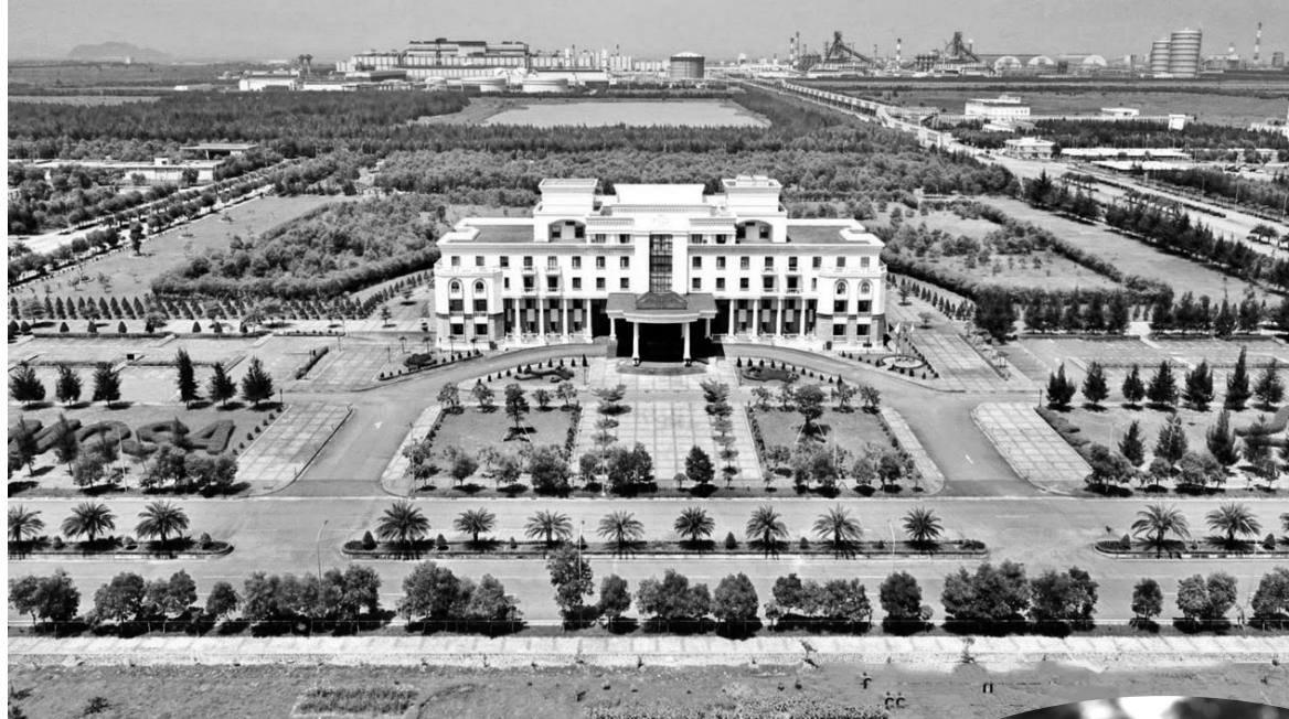
● Nhà hành chính Công ty FHS.
