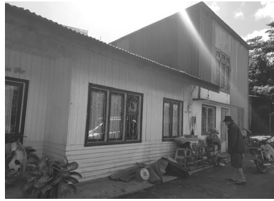
● Căn nhà ở phường 7 không thể sửa chữa vì dính “đường dự kiến”.
