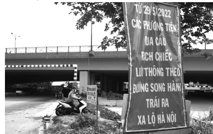
● Đường tạm chân cầu Rạch Chiếc bị đóng từ 29/5/2022.
