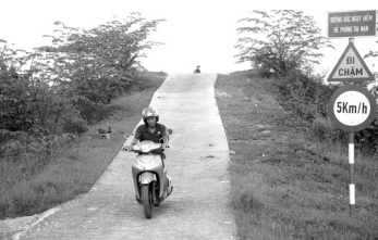
● Đường tạm lên cầu Trà Đình 2.
