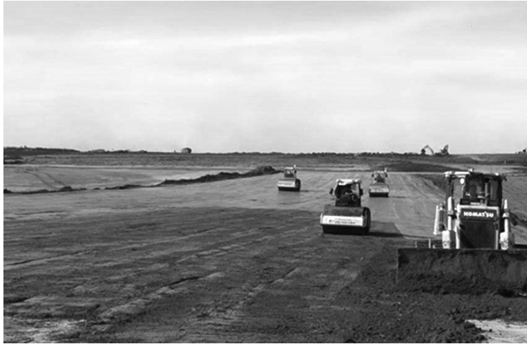
● ACV đã chỉ đạo nhà thầu xây dựng kế hoạch thi công cụ thể với từng mũi thi công trong dịp Tết Quý Mão vừa qua.
