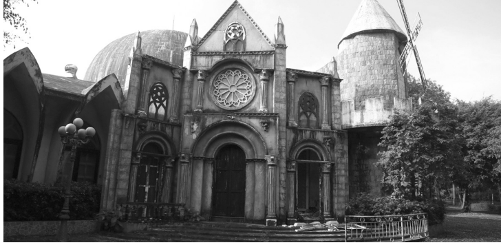
● Phía ngoài nhà chiếu hình vũ trụ có dấu hiệu xuống cấp sau thời gian dài không được sử dụng.
