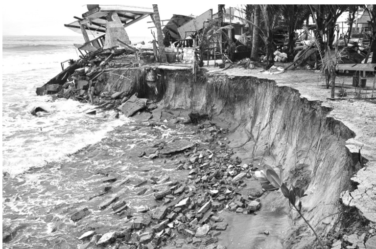
● Một ngôi nhà đã bị sóng biển đánh sập.
