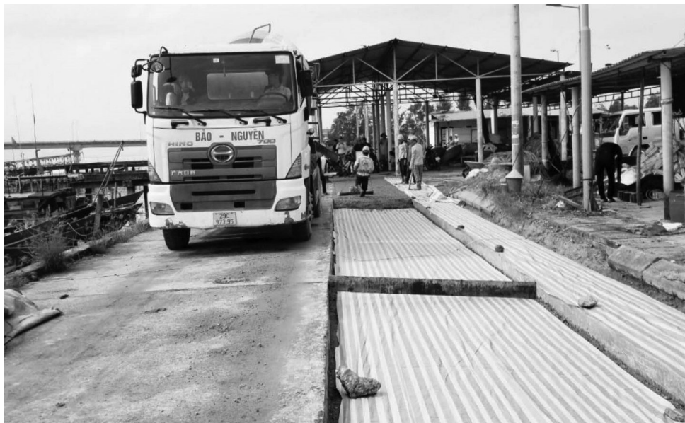
● Thi công đường nội bộ dự án cảng cá Tư Hiền.
