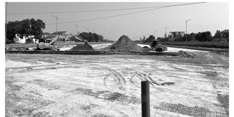
● Đường Vinh - Cửa Lò đang thi công.
