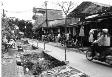
● Ngốn ngang một công trường xây dựng thuộc dự án.
