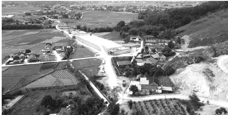
● Các đơn vị thi công đang tập trung phương tiện, máy móc thiết bị, công nhân đẩy nhanh tiến độ xây dựng Dự án.
