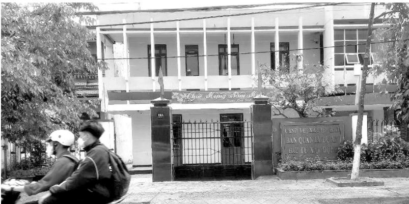
● BQL dự án đầu tư xây dựng TX Điện Bàn.
