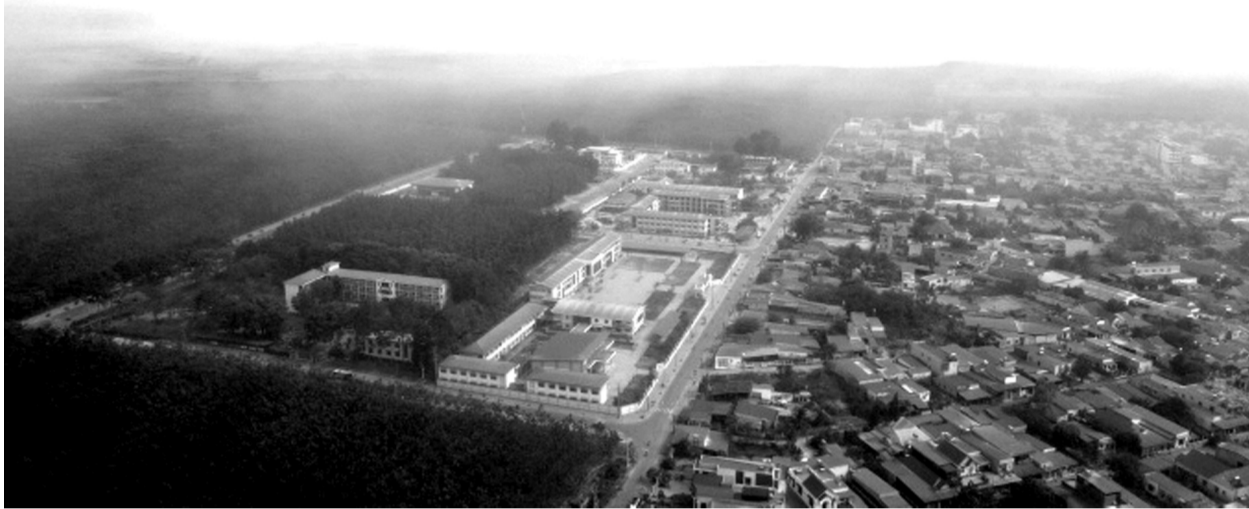
● Ô nhiễm bụi tại công trường sân bay Long Thành vượt quy chuẩn gần 20 lần.
