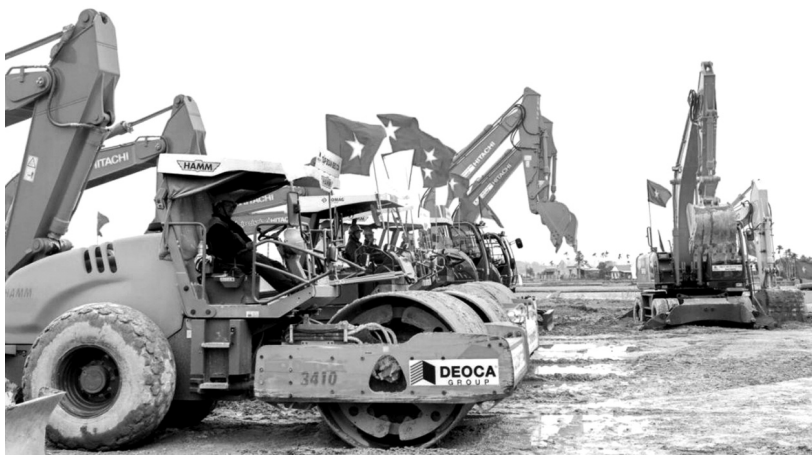
●Nhà thầu Đào Cả tăng cường nhân lực, máy móc thực hiện 3 gói thầu cao tốc Quảng Ngãi - Hoài Nhơn.
