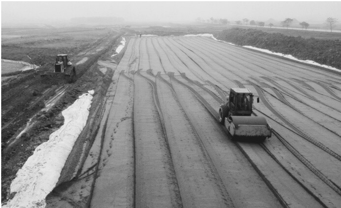
● Thi công dự án Diễn Châu - Bãi Vọt.
