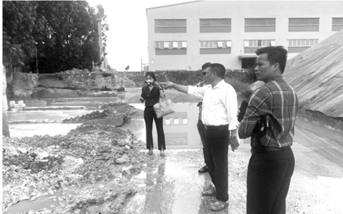
● Cán bộ Cty đưa PV đi thực tế quan sát hệ thống bể chứa nước thải.
