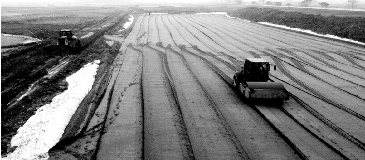
● Thi công cao tốc Diễn Châu - Bãi Vọt.
