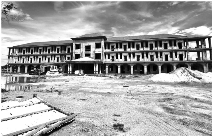
● Dự án mới đã hoàn thành 90% khu nhà dạy học.
