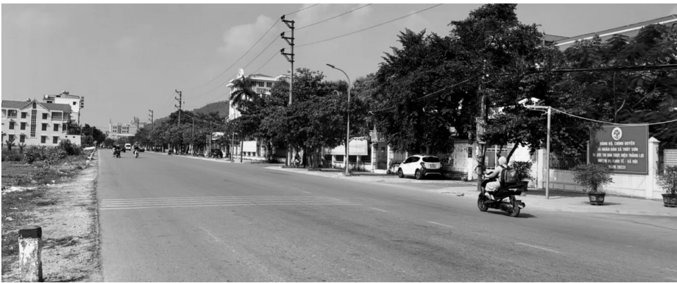
● Các tuyến đường giao thông tại xã Thủy Sơn được đầu tư xây dựng khang trang, rộng rãi.
