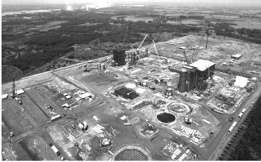
● Dự án Nhà máy Nhiệt điện Nhơn Trạch 3 và 4 đang đẩy mạnh thi công. (Ảnh: PVN)
