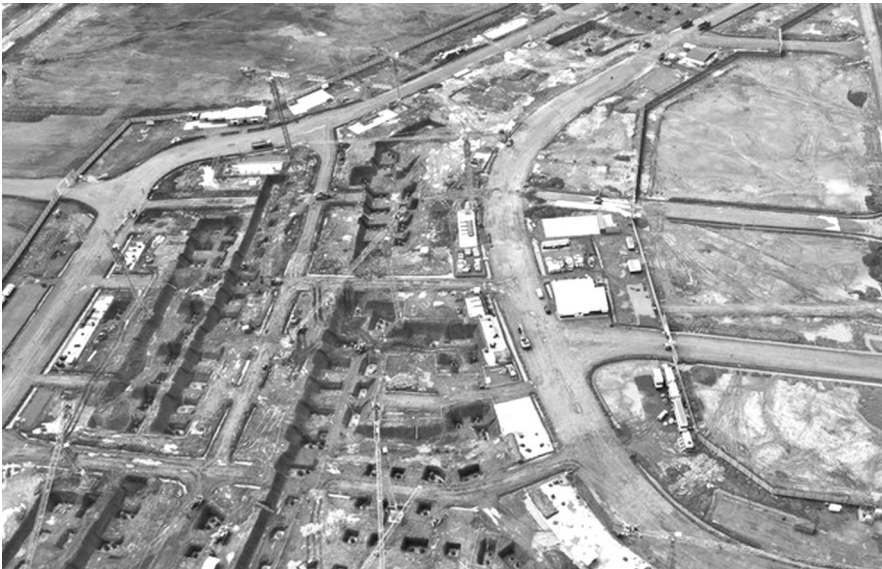
● Một góc công trường sân bay Long Thành. (Nguồn ảnh: ACV)
