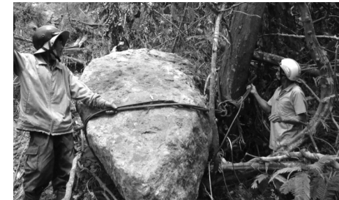
● Một khối đá khác có nguy cơ rơi được gia cố bằng dây curoa.
