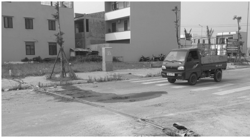
● Đường ống được người dân kéo khá xa và thường xuyên bị vỡ gây thất thoát, hao phí nước.
