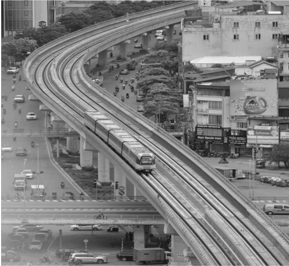
● Dự án tuyến ĐSDT số 3, đoạn Nhổn - ga Hà Nội vừa hoàn thành tuần thứ tư của giai đoạn vận hành thử nghiệm. (Ảnh: Ban Quản lý đường sắt đô thị Hà Nội)
