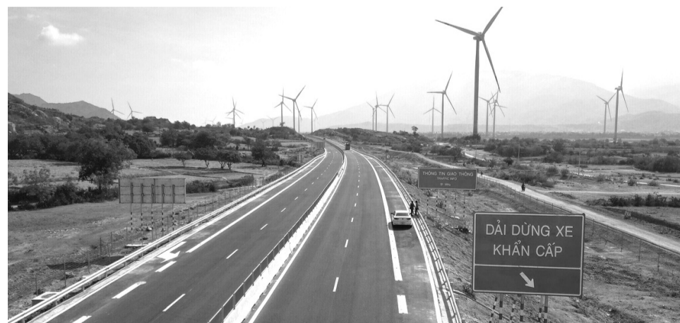
Cao tốc Cam Lâm - Vĩnh Hảo đoạn qua cánh đồng điện gió huyện Thuận Bắc, Ninh Thuận. (Ảnh: Việt Quốc)
