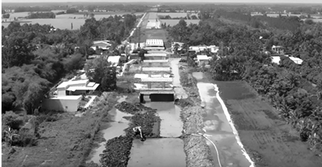
● Nhiều dự án giao thông trọng điểm tại ĐBSCL thiếu cát đắp nền. (Ảnh: Bộ GTVT)
