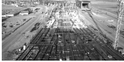
● Một góc công trường xây dựng sân bay Long Thành.
