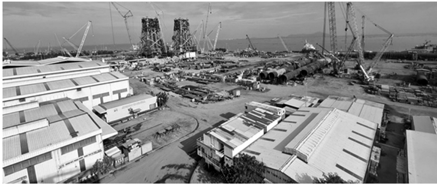
●Cảng Dịch vụ Dầu khí của PTSC tại Vũng Tàu - nơi sản xuất chân đế dự án điện gió ngoài khơi. (Ảnh: Minh Hữu)
